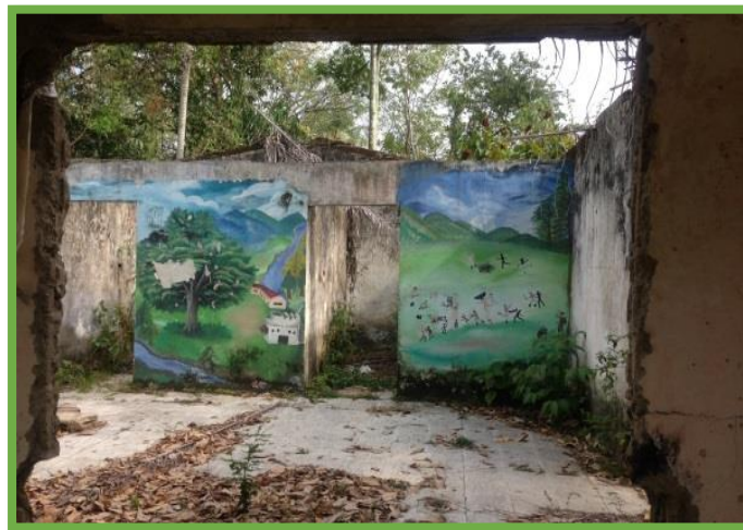
Foto 8. Casa en ruinas en la comunidad de Mampujan, Municipio de Marialabaja, archivo institucional UAEGRTD Territorial Bolívar año 2012
